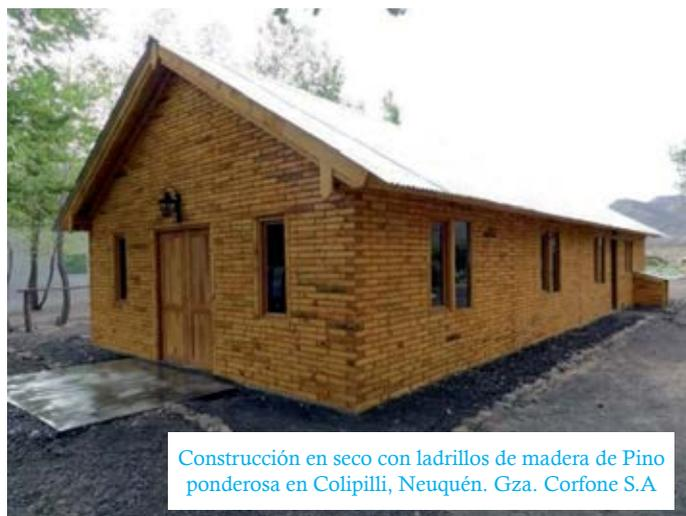
Construcción en seco con ladrillos de madera de Pino ponderosa en Colipilli, Neuquén. Gza. Corfone S.A
